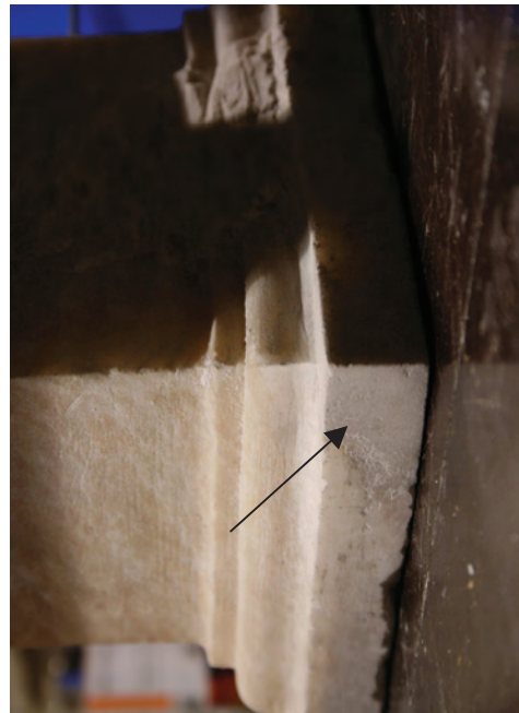
Abb. 15: Ergänzung einer Ecke an der Plinthe einer Skulptur des Ulrich Monuments, Foto: Silvia Gering, Juni 2009
