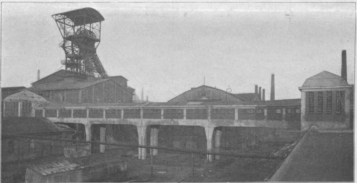
Abbild. 12. Blick auf die Gesamt- Anlage. Im Vorder- grund der Ver- bindungs- Gang zum Haupt- Förder- Schacht.
