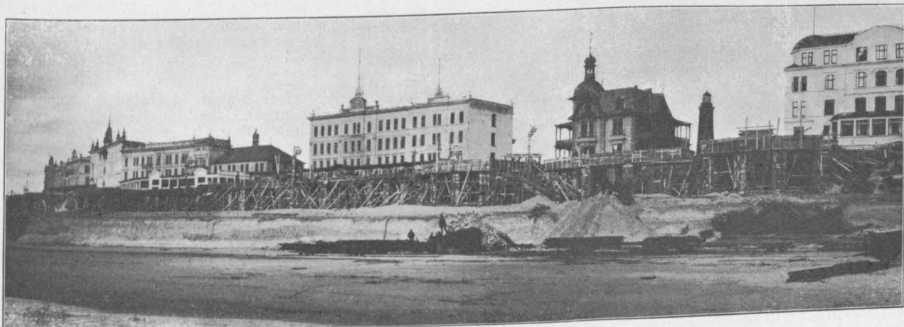
Abbildung 14. Gesamtansicht der im Bau begriffenen Wandelhalle. Aufstellung der Fassaden-Schalung.
