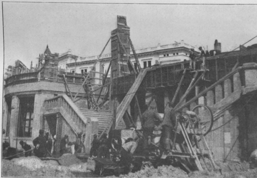
Abbildung 16. Betonieren des Hauptgesimses und des Geländers nebst Aufbauten.
