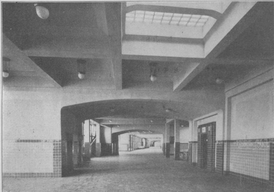
Abbildung 6. Blick in die Wandelhalle.
