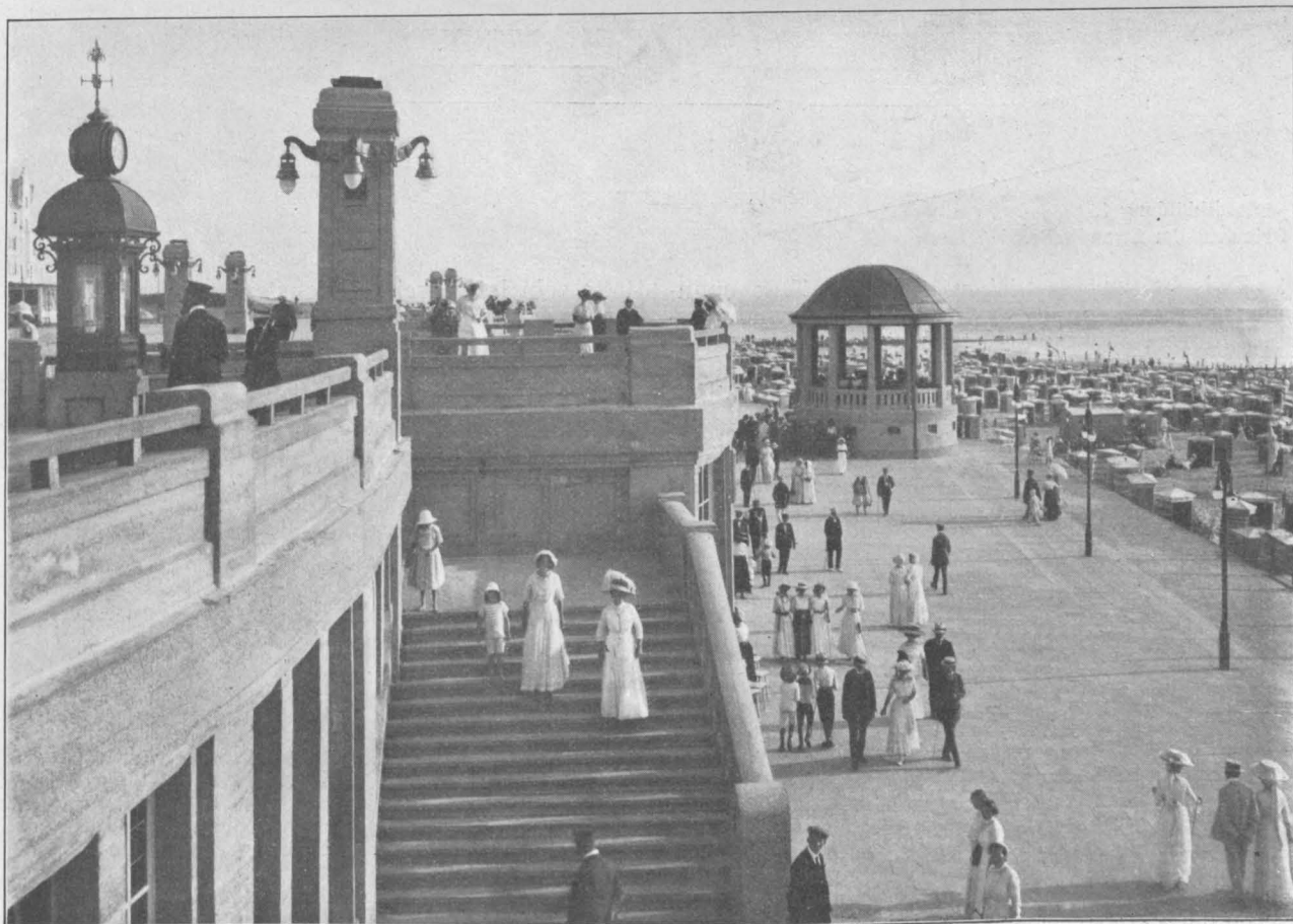
Abbildung 3. Wandelhalle in Borkum. Blick gegen die Freitreppe. Architekten: Ziesel & Friederich in Köln.
