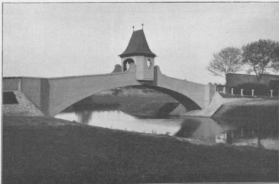
Abbildung 1. Ansicht des fertigen Bauwerkes.
