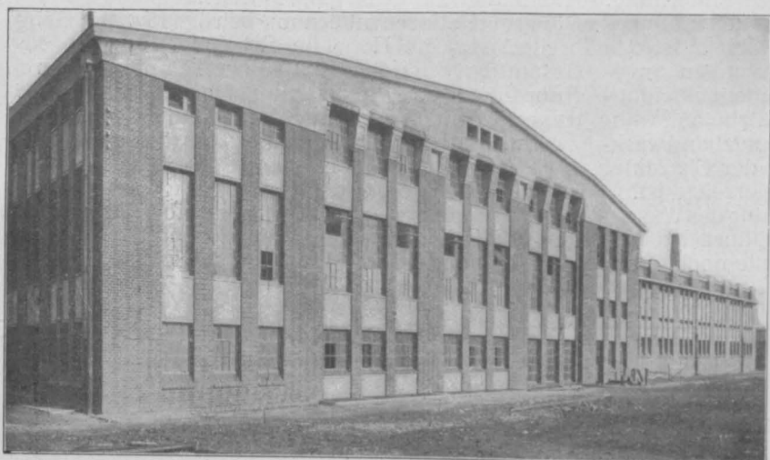
Abbildung 8. Äußere Ansicht des Maschinenhauses.
