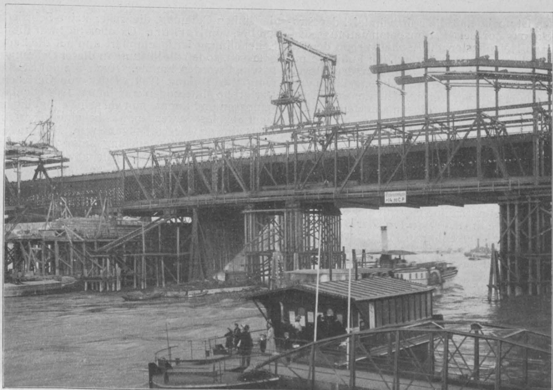
Abbildungen 17—19. Montage der neuen Eisenbahnbrücke in verschiedenen Stadien. (Unten Montage der rechten Seitenöffnung, darüber Gerüstbrücke der Mittelöffnung, oben fertig montierte Brücke.)
