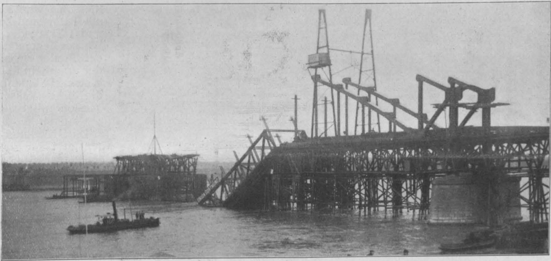
Abbildung 13. Vom Bau der Südbrücke. Einstürztes Montagegerüst der Mittelöffnung. 9. Juli 1908.
