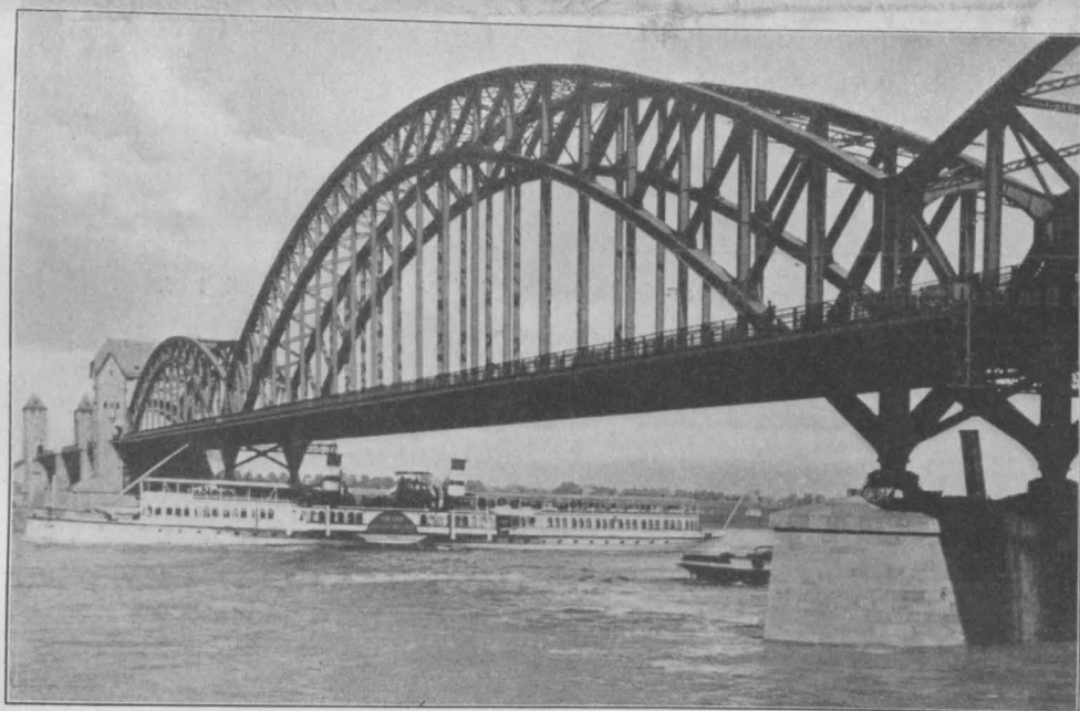
Abbildung 8. Südbrücke von unterstrom aus gesehen. (Phot. von Ed. Hölzermann in Köln a. Rh.)
