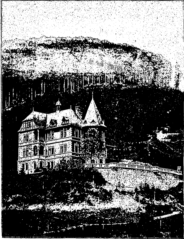
Haus Schönau in Hüttensteinach bei Sonneberg i. Th. Ansicht von der Südwest-Seite.
